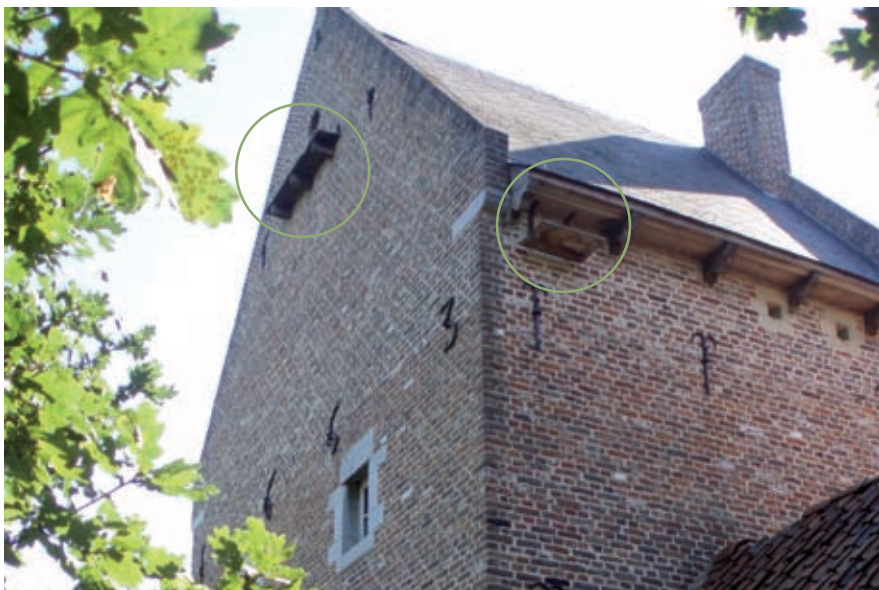
Mestplankjes kunnen ook nuttig zijn bij aanliegopeningen voor duiven
