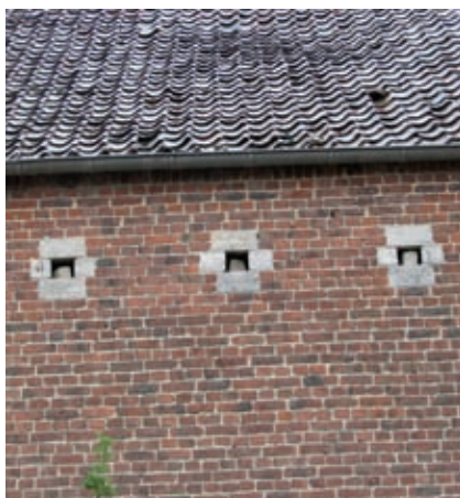
Steigergaten zijn gedeeltelijk afgesloten met bakstenen of natuurstenen blokken
