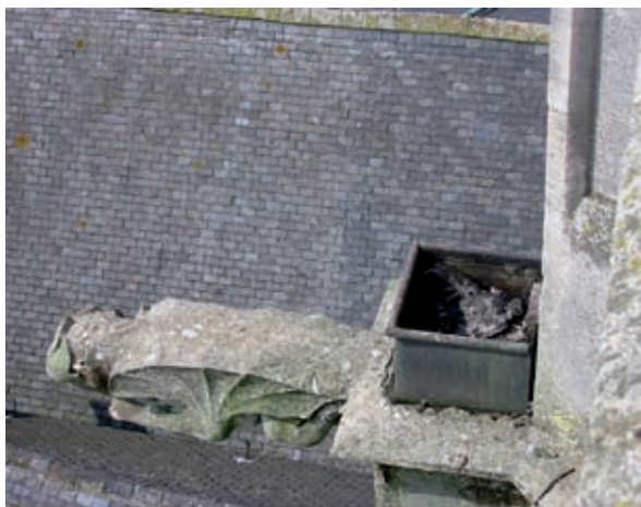
Een dode duif in de vergaarbak verhindert een vlotte regenwaterafvoer
