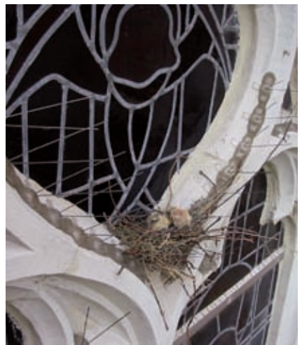
Duivennest ondanks – of dankzij – de aangebrachte pennen
