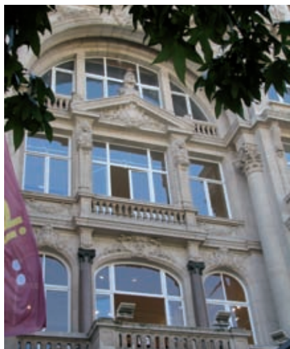
Netten schermen de volledige gevel af en vallen nauwelijks op...
